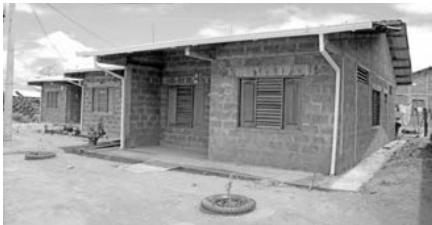
Foto 11. Estructura de las viviendas en el nuevo Bellavista.
